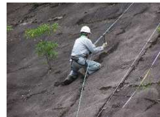
打音調査実施状況
