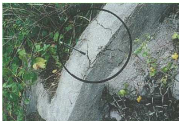
写真 2.14 法枠の割れ
