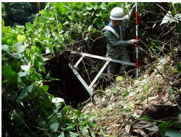
写真 2.16 植生に押し倒された支柱
