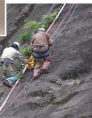
地中レーダー実施状況と探査装置
