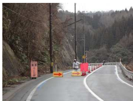
片側車線規制
