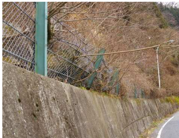
写真 2.27 支柱の倒れ
