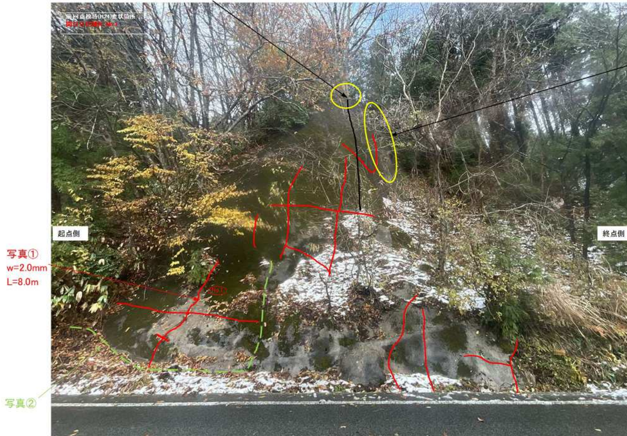
写真③ 亀裂(空洞化) 幅=40mm
