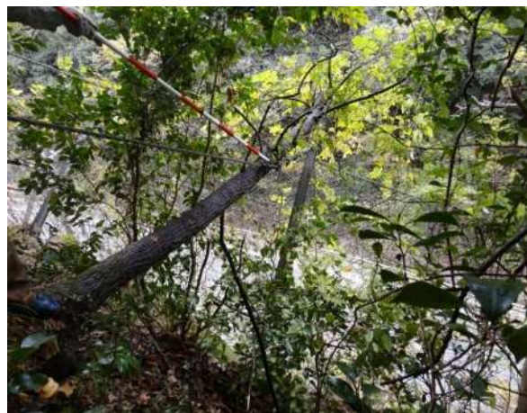
写真 2.17 倒木による支柱の傾倒
