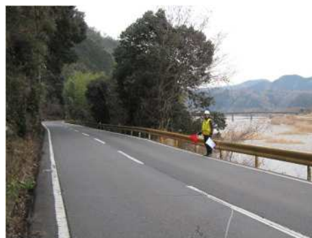
法尻に配置した見張り員
