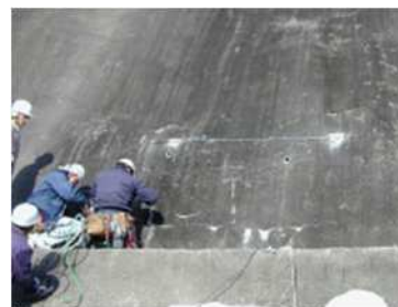
モニタリング状況
