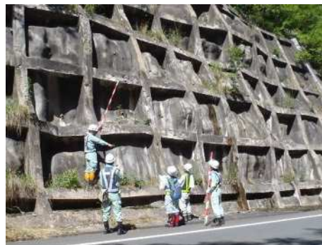
目合わせ点検の状況
