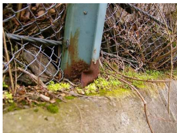
写真 2.29 支柱の錆び
