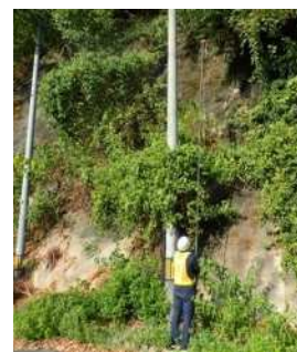
写真 1.3 ポールカメラによる調査
