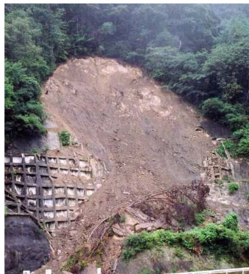
写真 2.12 法枠を巻き込んだ斜面崩壊
