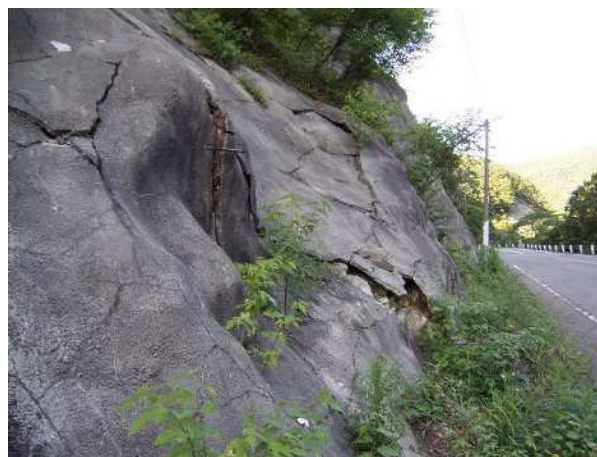
写真 2.5 浮き(全体的・寸法大の例) 全体の 50%程度以上あれば「全体的」と評価する
