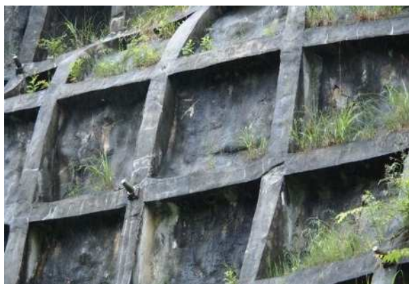
写真 2.13 法枠の割れ
