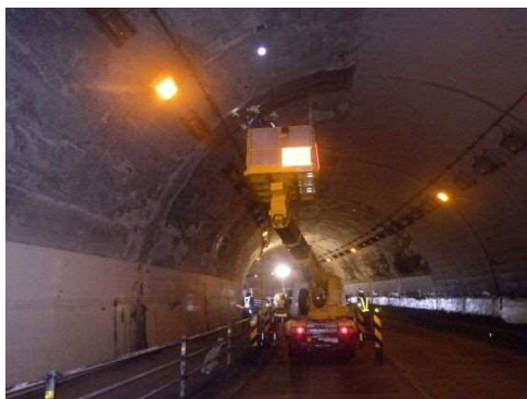
写真 3-1 FRP ネット設置状況
