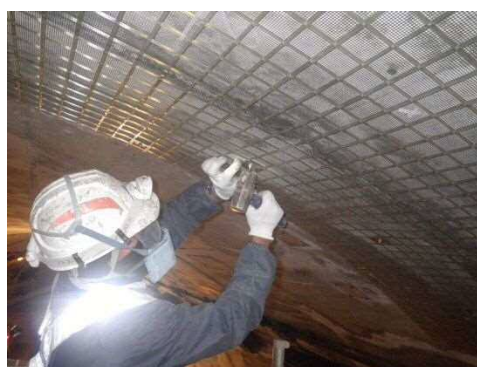
写真 3-1 FRP ネット設置状況
