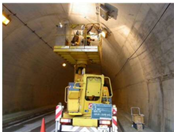
写真 2-1 トンネル点検状況
