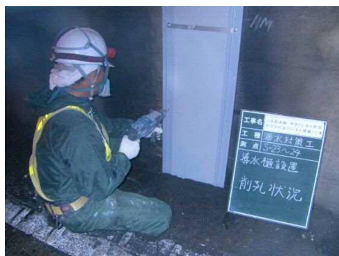
写真 3-2 線導水工
