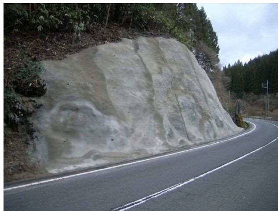
写真 3-1 既設モルタルの撤去+再吹付
