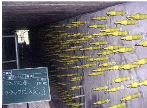
写真 4－2 ひび割れ注入状況
