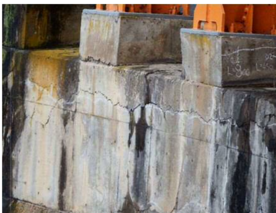
受台のひび割れ
