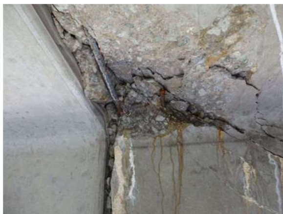
はく落を伴う鉄筋露出（頂版）
