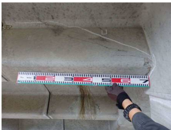
ひび割れ、はく離・はく落（横梁）
