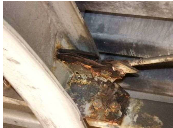
ガセットプレート部分の腐食
