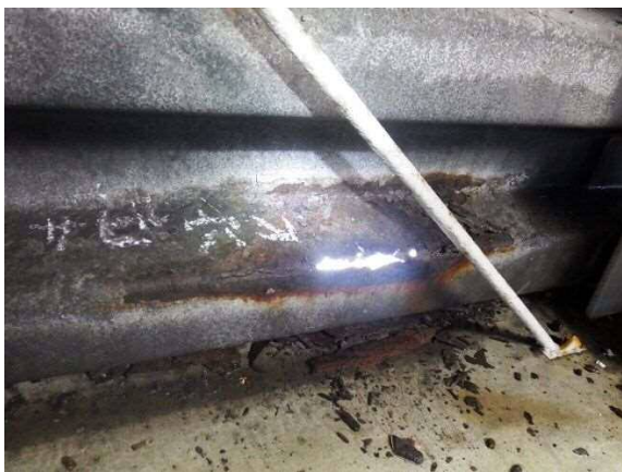
頂版の断面欠損
