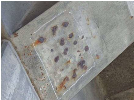
PC 鋼材からの錆汁（主梁）
