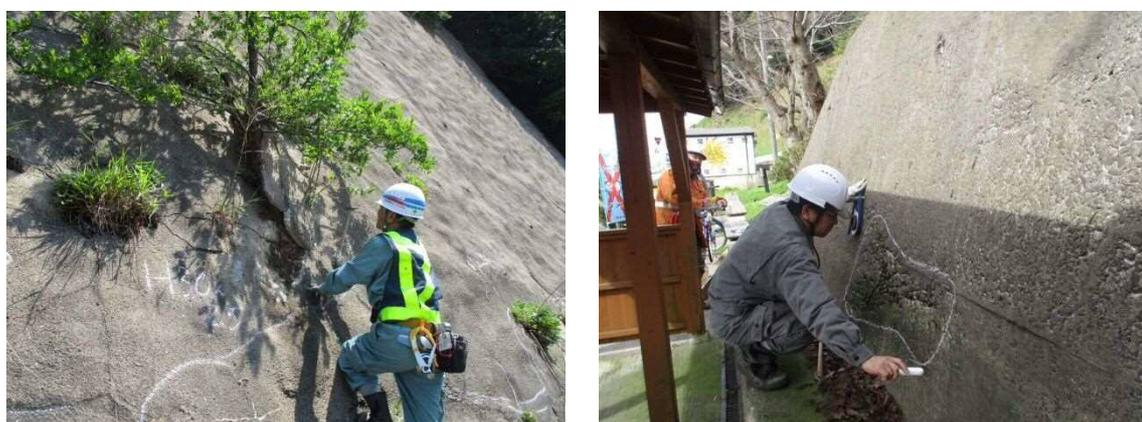
写真 2-1 法面構造物点検状況
