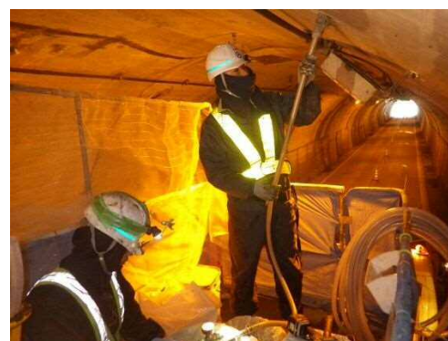
裏込注入状況
