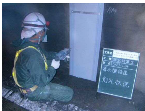
写真 3-2 線導水工
