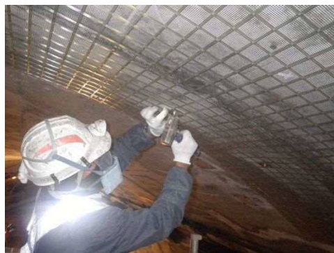
写真 3-1 FRP ネット設置状況
