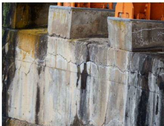
受台のひび割れ
