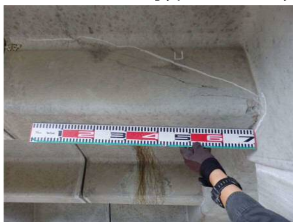
ひび割れ、はく離・はく落（横梁）
