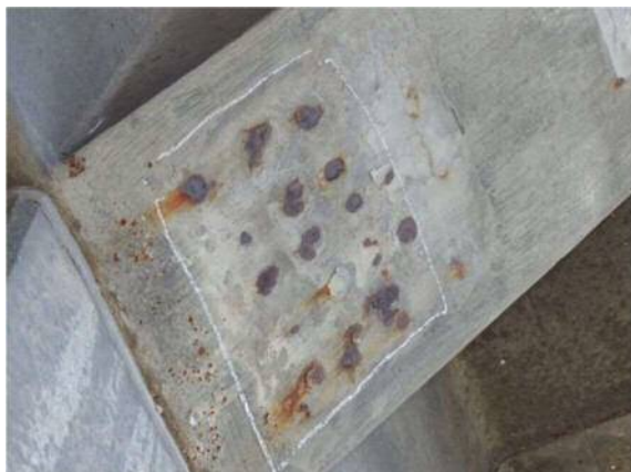
PC 鋼材からの錆汁（主梁）
