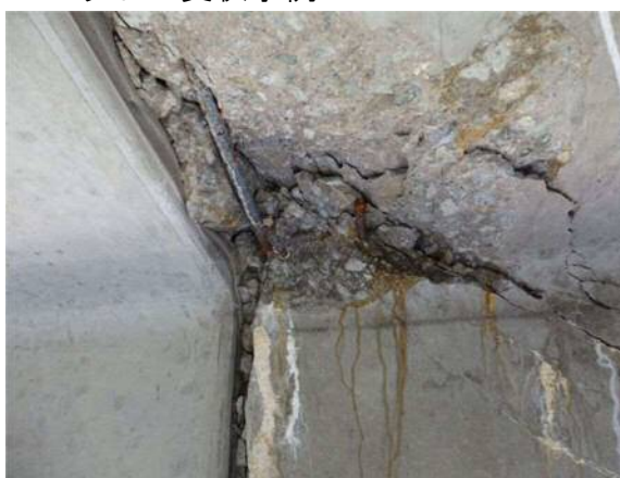
はく落を伴う鉄筋露出（頂版）
