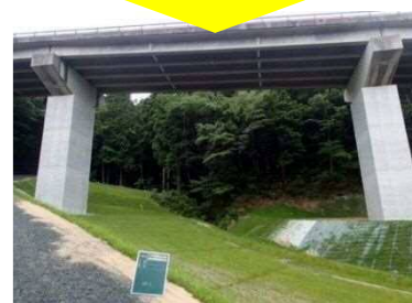
橋梁の補強、落橋防止対策 [市木井原線：邑智郡邑南町]
