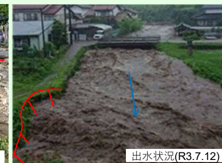
被害状況(護岸欠壊)
