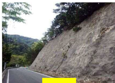
道路の落石対策
