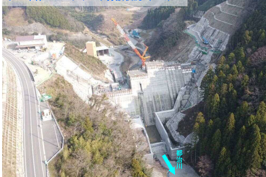
ダム本体のコンクリート打設状況 (R4.3)
