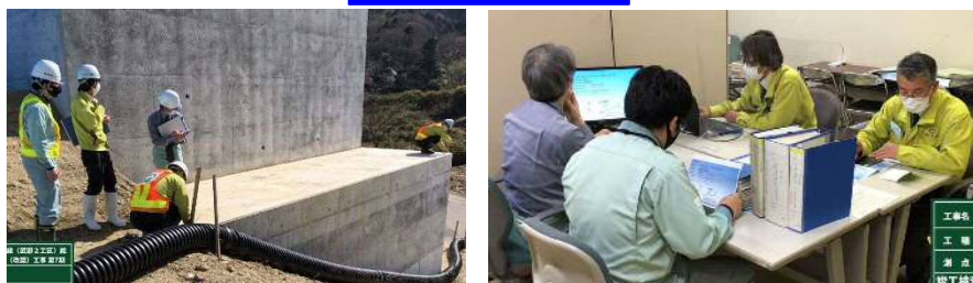
現場立会および対面式の資料確認
