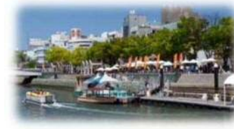
親水護岸の利用 (新町川／徳島市)
