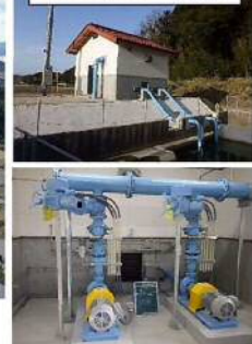
揚水機場の更新
