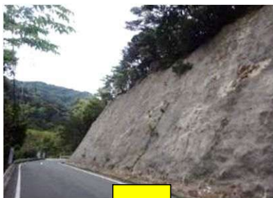
道路の落石対策
