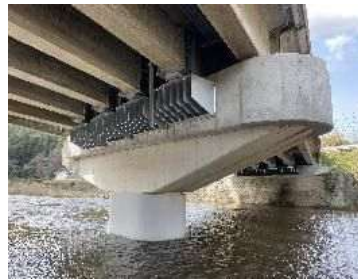
水平力分担構造
