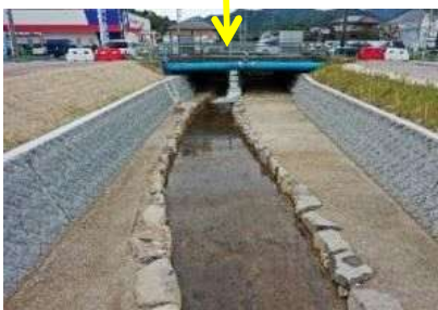
流域治水対策が進む中川 [中川：松江市黒田町]
