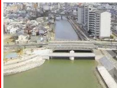
天神川水門（H27.1完成）
