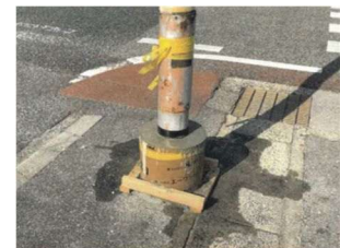
緊急対応 (根巻コンクリート)
