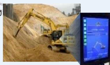
3Dデータを利用した機械施工
