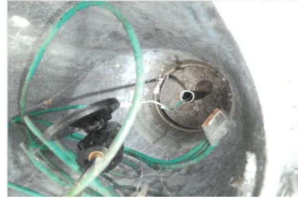
支柱内部の目視点検
