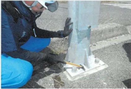
近接目視、打音調査
