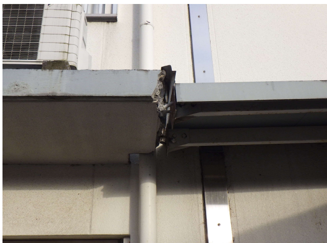
布部ダム 管理所建物底の破損 (安来市広瀬町布部)
