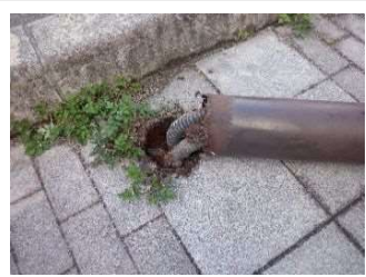
・令和7年1月発生(出雲市大津町) ・歩道照明柱が強風で倒壊し、 集団登校中の児童1名が負傷
