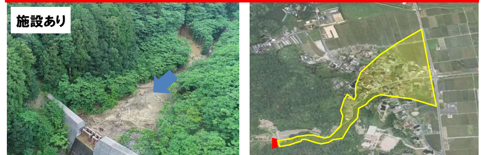
砂防堰堤による土砂捕捉
