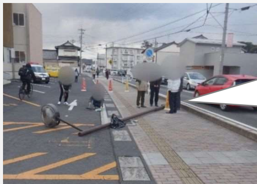
・令和7年1月発生(出雲市大津町) ・歩道照明柱が強風で倒壊し、 集団登校中の児童1名が負傷
