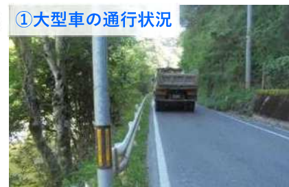
②落石状況
