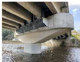
水平力分担構造
