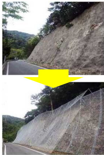
道路への落石防護ネット設置 [西郷都万郡線：隠岐の島町]
