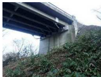
落橋防止構造
