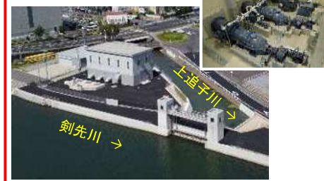
上追子川排水機場（R3.9完成）
