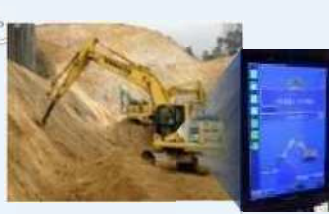
3Dデータを利用した機械施工
