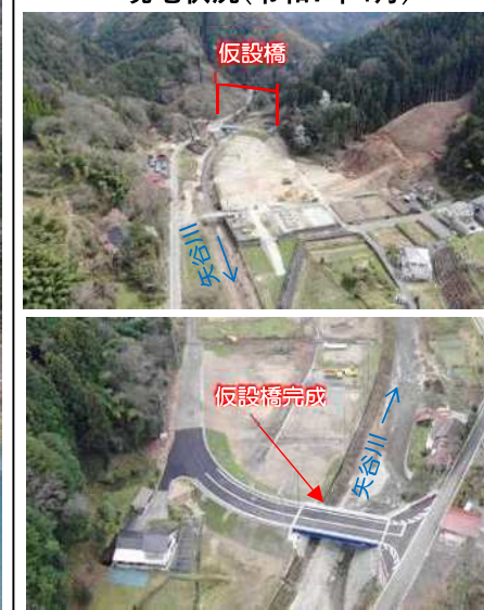
現地状況(令和7年4月)
