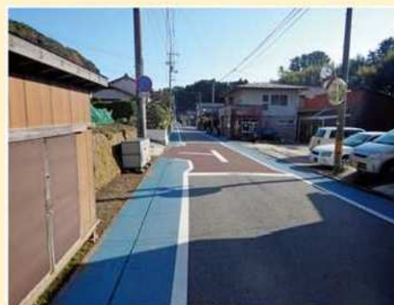
（一）池田中町線（隠岐の島町）
