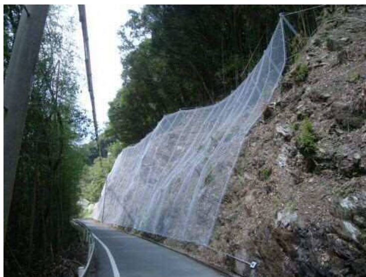
図-2 実施例（落石防護網）
