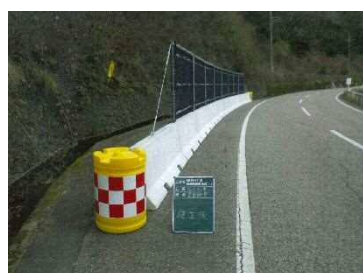
簡易防護柵 国道488号 (益田市)
