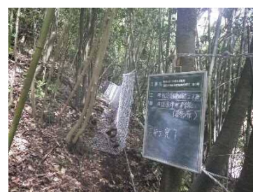
立木柵 (主) 温泉津川本線 (川本町)
