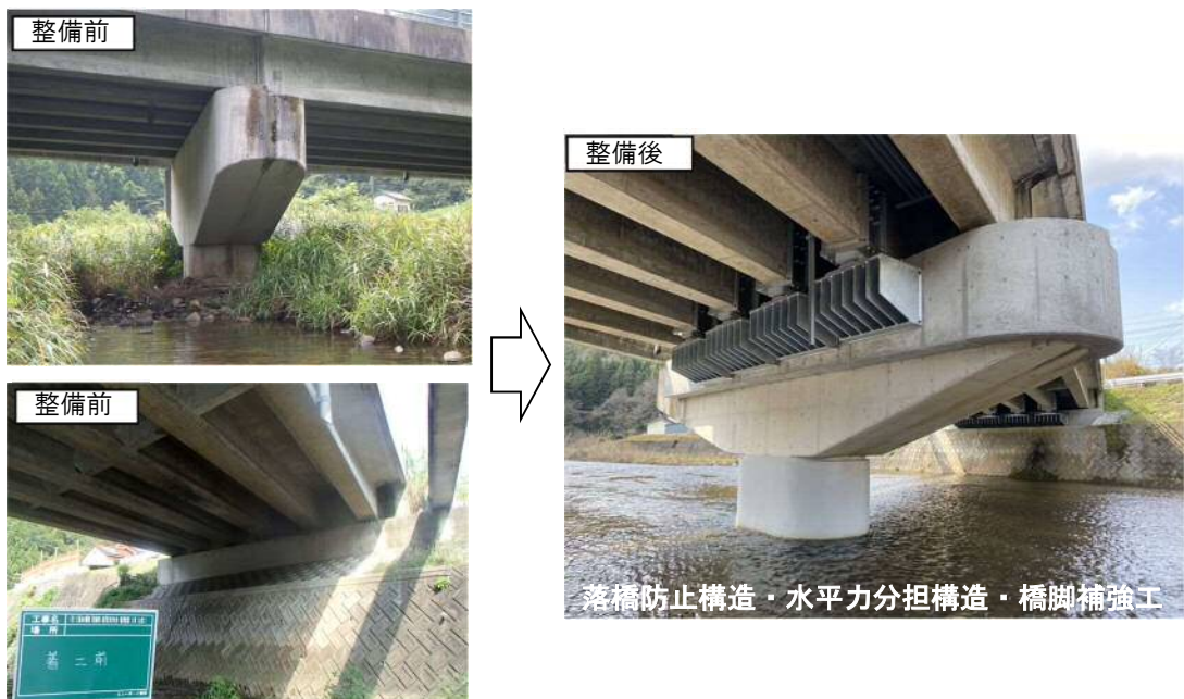
槇原橋 (主)三瓶山公園線(大田市大田町)
