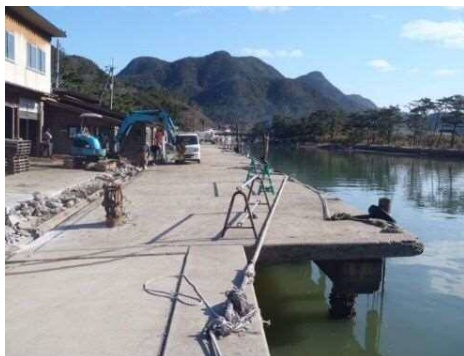
写真－１１ 健全な状態の栈橋
