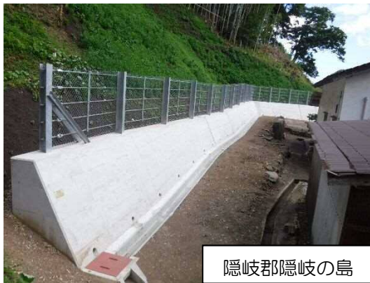
写真－３ 擁壁工
