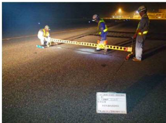
写真一 4 滑走路定期点検状況
