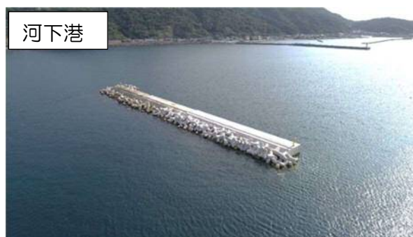
写真-6 沖防波堤の整備
