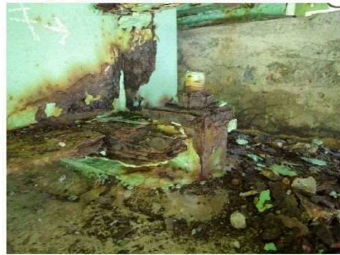
令和元年点検
