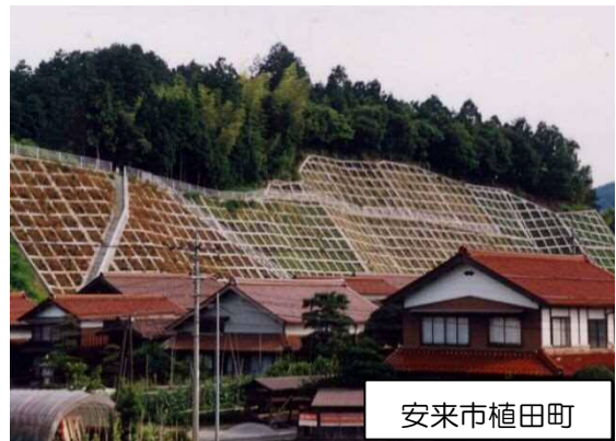
写真－４ 斜面对策工（法枠工）
