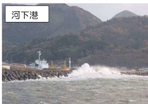
写真-5 海上が荒れた際の岸壁状況
