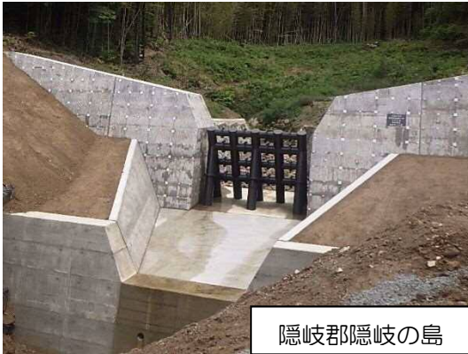
写真－１ 砂防堰堤
