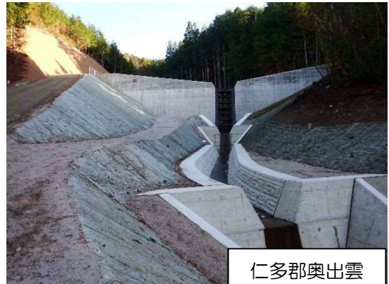
写真－２ 砂防堰堤と流路工
