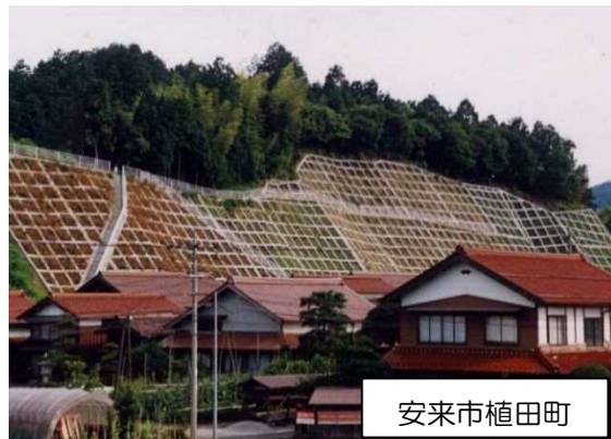
写真－４ 斜面对策工（法枠工）
