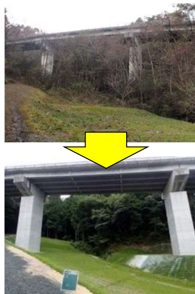
橋梁の補強、落橋防止対策 [市木井原線：邑智郡邑南町]
