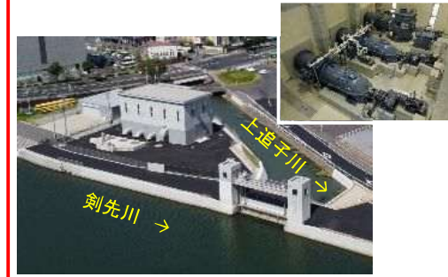
上追子川排水機場（R3.9完成）
