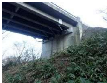
落橋防止構造
