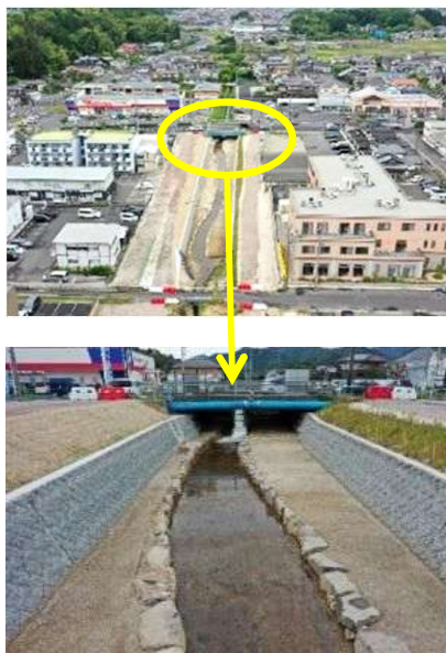
流域治水対策が進む中川 [中川：松江市黒田町]
