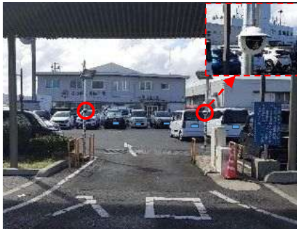
【ナンバー認識カメラ設置状況】
