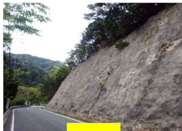
道路の落石対策
