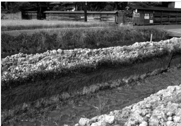
第13区土層堆積状況 (北から)
