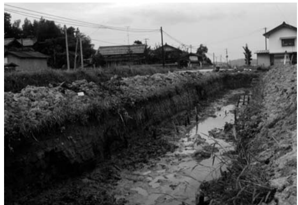
第14区完掘状況 (北から)
