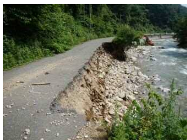
上流域の被災状況
