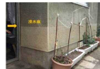
家屋等の浸水痕跡
