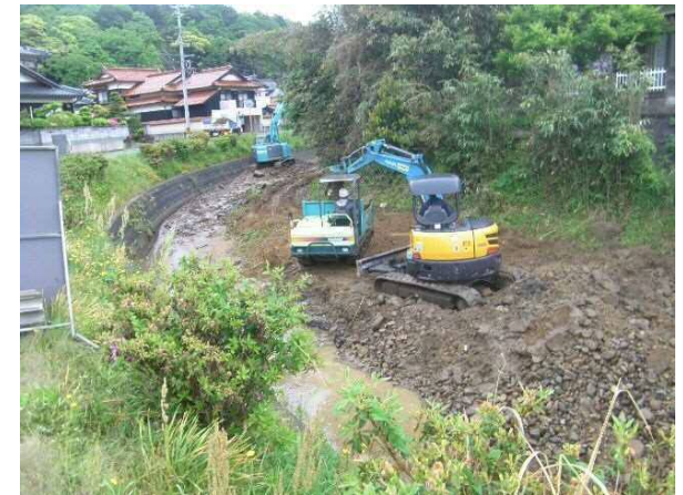
堆積土砂の撤去状況(新川)
