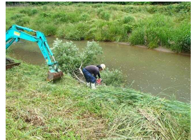
支障木等の撤去状況(都治川)
