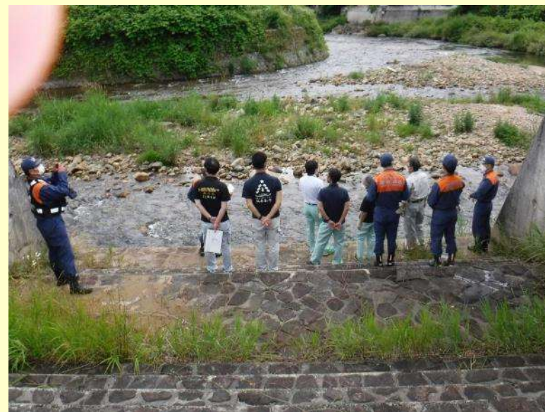
神戸川(飯南町野萱)危険な箇所の確認
