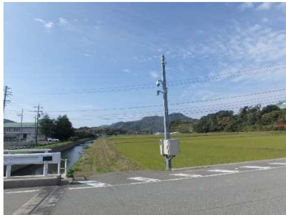
諏訪川（芦田橋）
