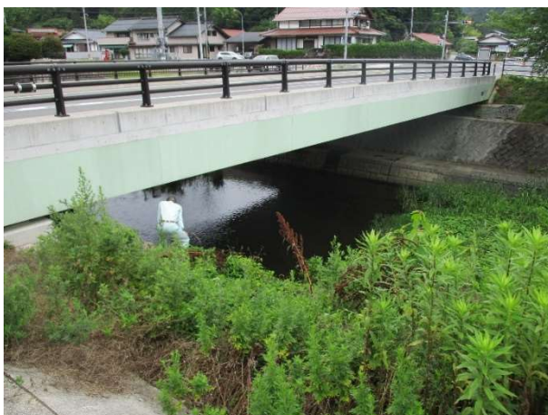
八尾川 重要水防区域
