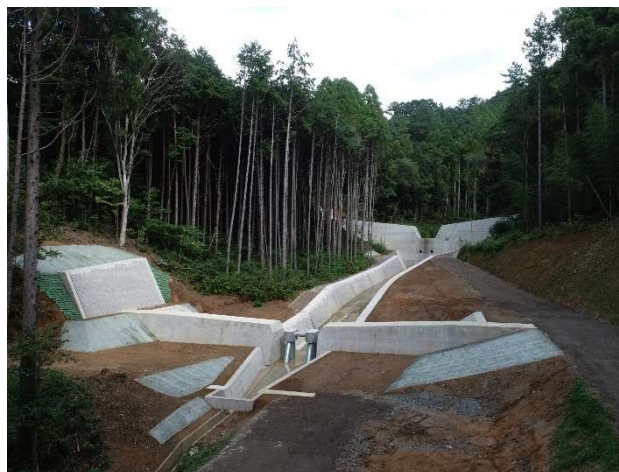
⇐流路工、下流側(流木捕捉)
