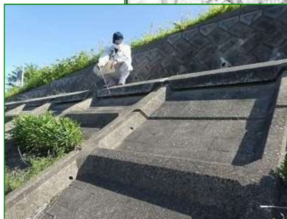
施設点検の様子（益田川）
