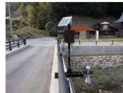
津和野町 名賀川 白井橋
