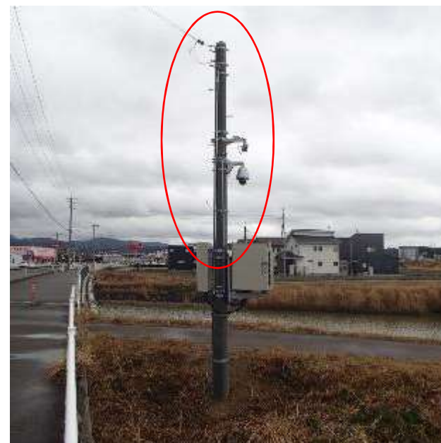
整備事例〔益田川（今市川樋門）〕
