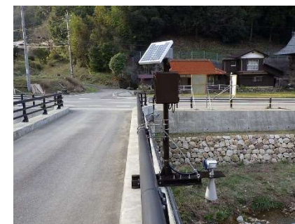
津和野町 名賀川 白井橋
