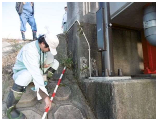
重要水防区域の点検状況
