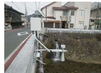
吉賀町 鹿足河内川 六日市橋
