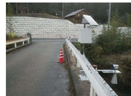
津和野町 津和野川 横瀬橋
