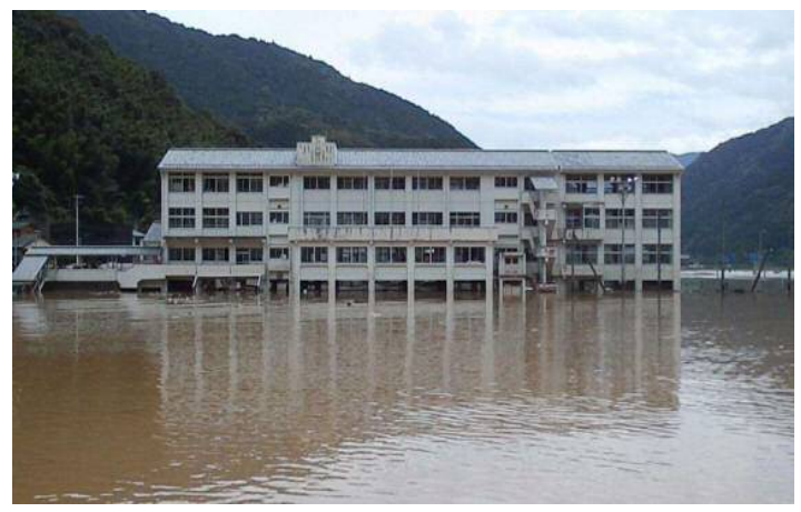
平成26年8月 避難所2階の浸水 (徳島県)
