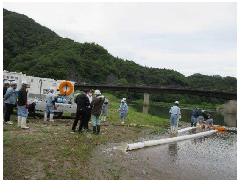
〈江津会場〉 日時：令和5年5月30日 6月15日 計2回 訓練場所：江津市桜江町市山 参加者：島根県浜田県土整備事務所 江津市 株式会社井上組
