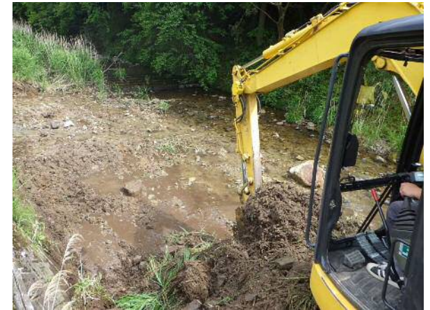
堆積土砂の撤去状況
