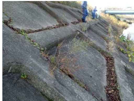
現地点検状況
