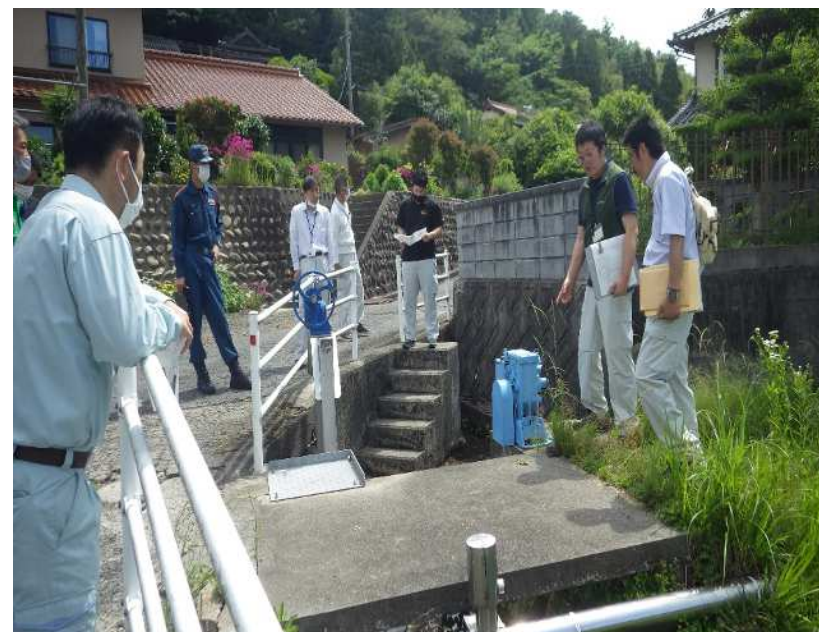
水門樋門点検（R5.6 大田町）
