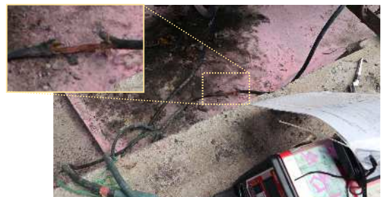
溶接機ケーブル被覆の損傷状況
