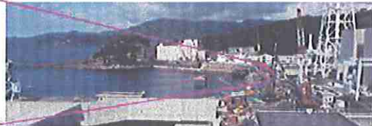
1, 2号機エリア (工事中)
