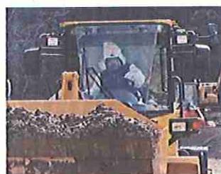
ホイールローダによる がれき撤去訓練
