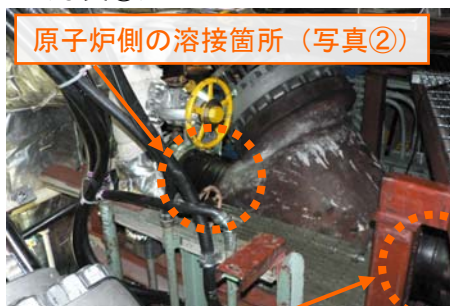
格納容器壁側の溶接箇所 (写真③)
