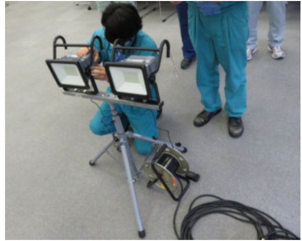
バッテリーの外観点検
