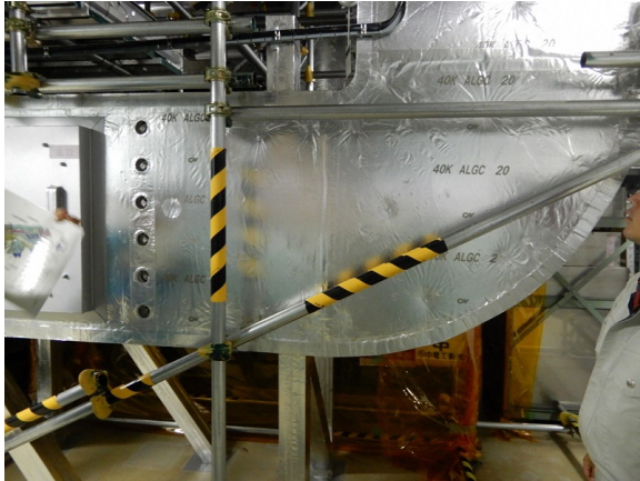
(1) 外気処理装置出口側ダクト外観 (角型から丸型へ形状を見直した箇所)
