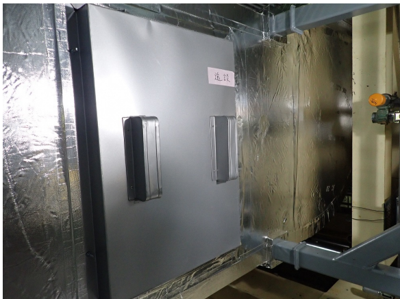
(5) 仕様変更後のダクト・点検口外観 (再循環ライン合流部手前のローポイント)
