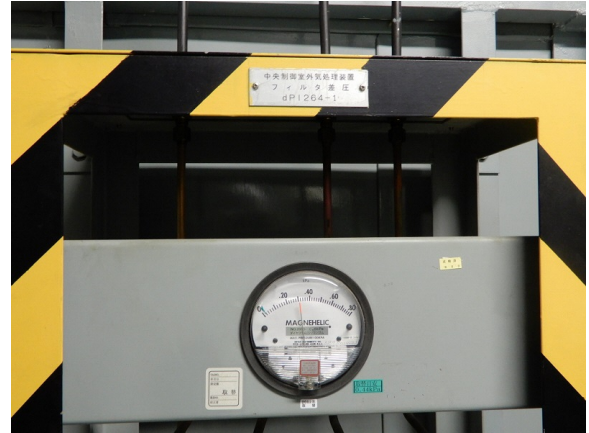
(2) 外気処理装置フィルタ差圧計
