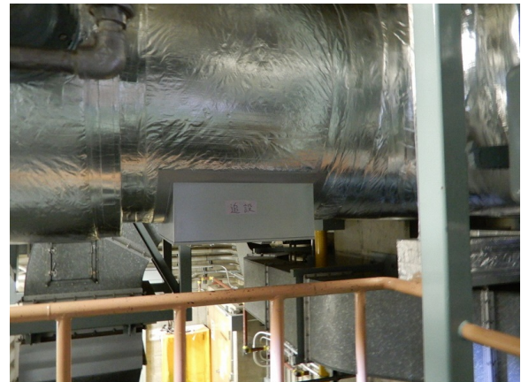
(4) 仕様変更後のダクト外観 (外気取入れライン)
