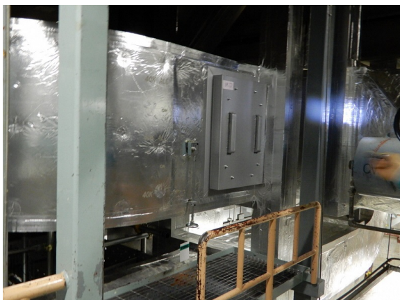
(3) 仕様変更後のダクト外観 (外気取入れライン)
