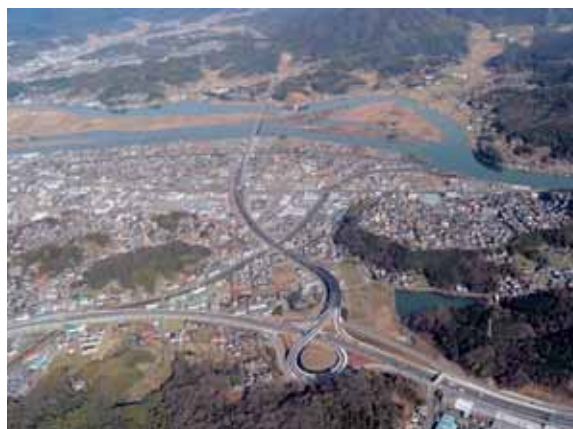
松江第5大橋の建設
