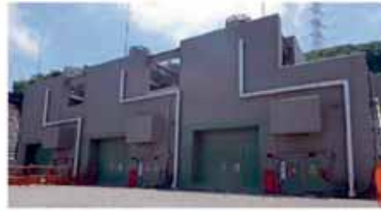
ガスタービン発電機
