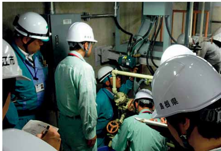
立入調査の様子
