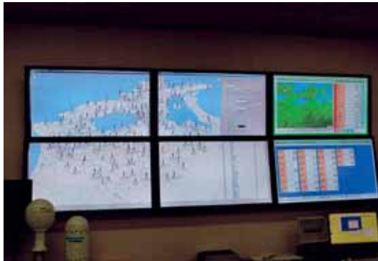
モニタリングポストの線量率監視
