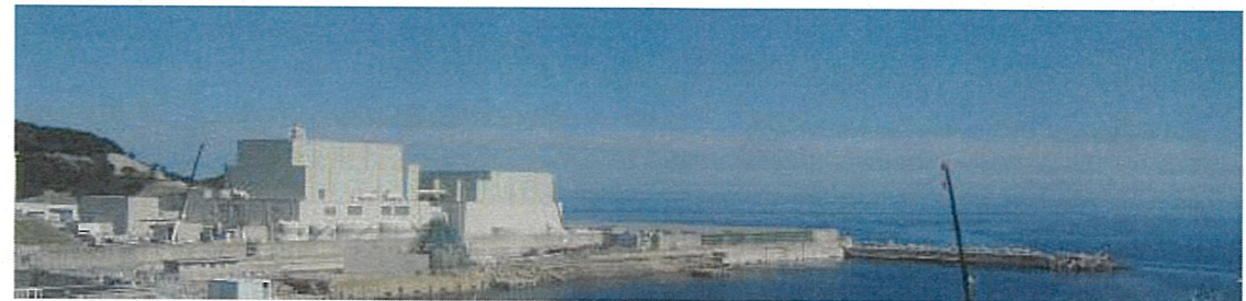
敷地東側からの全景
