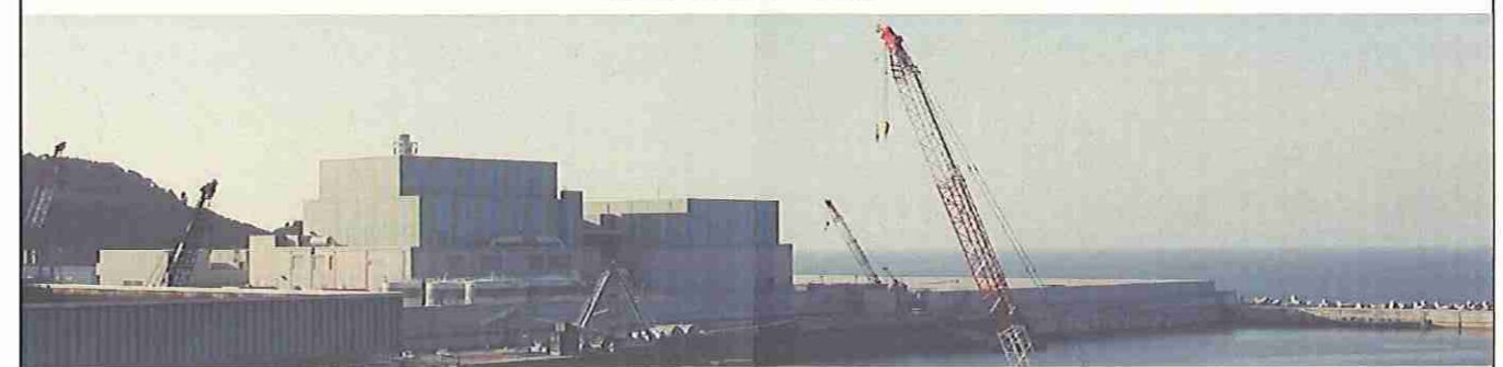
敷地東側からの全景
