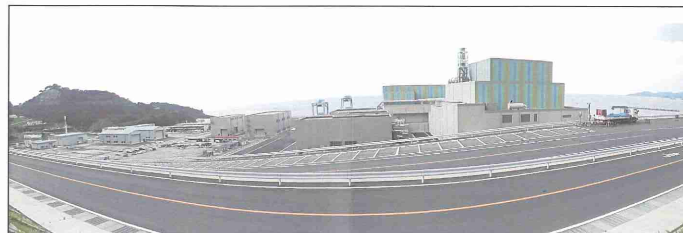
敷地南側からの全景
