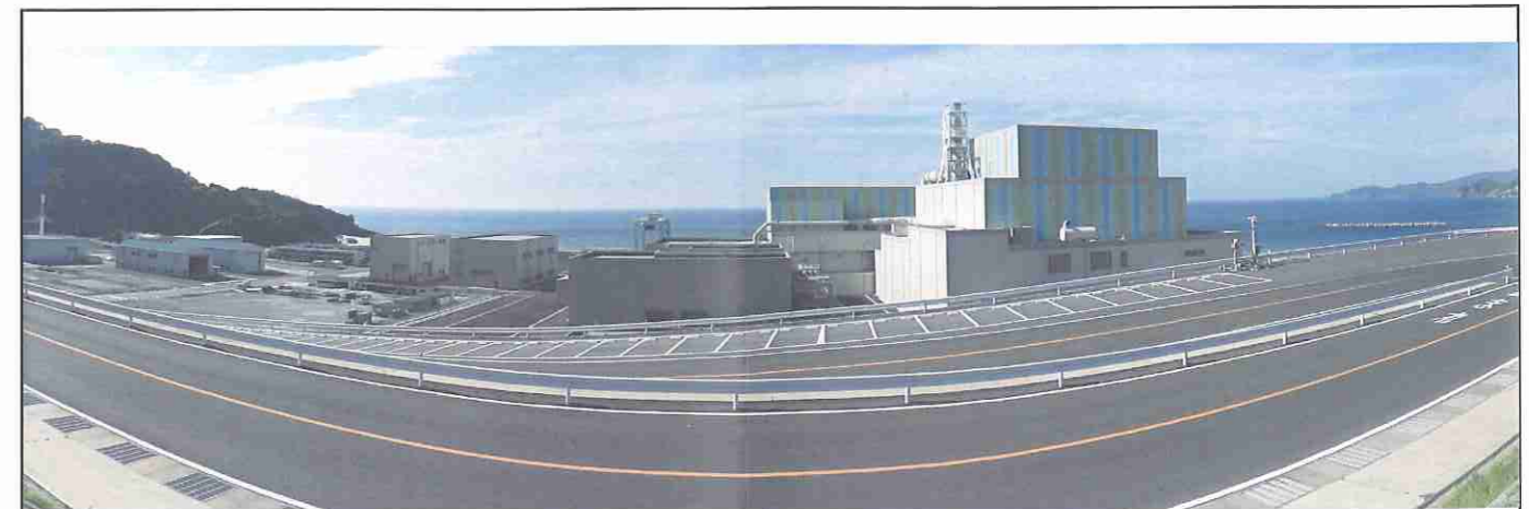
敷地南側からの全景
