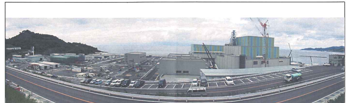
敷地南側からの全景
