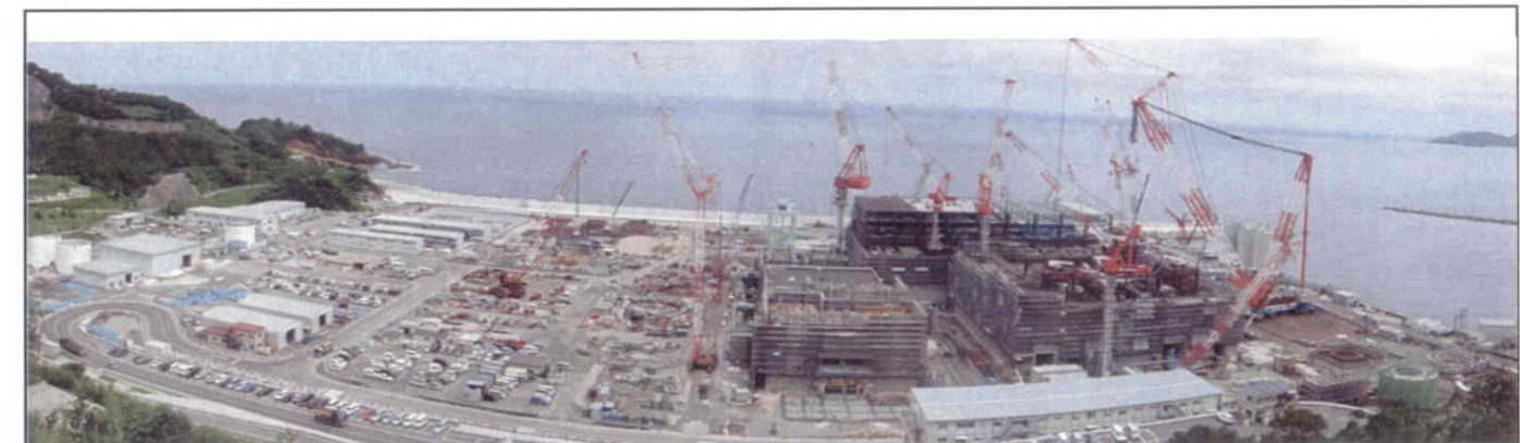
敷地南側からの全景
