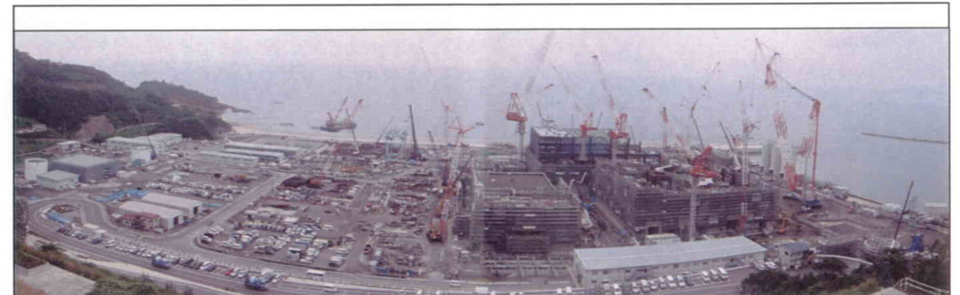
敷地南側からの全景
