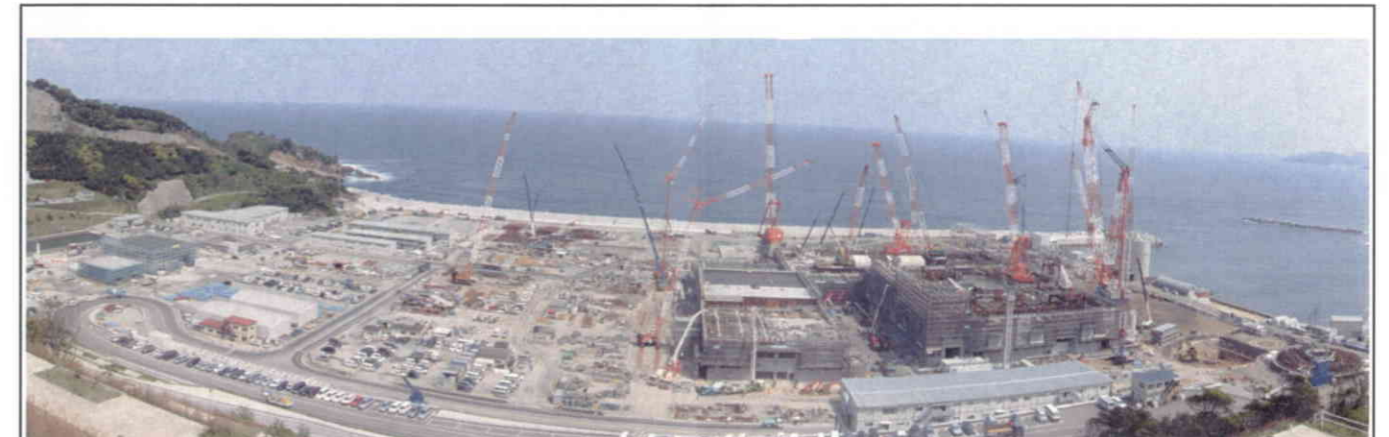
敷地南側からの全景
