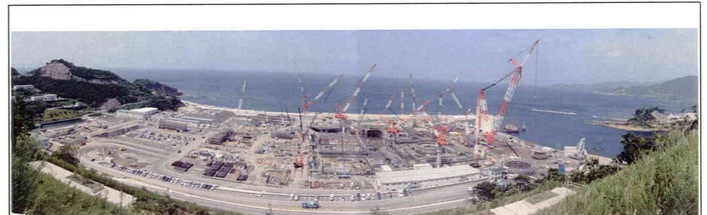
敷地南側からの全景
