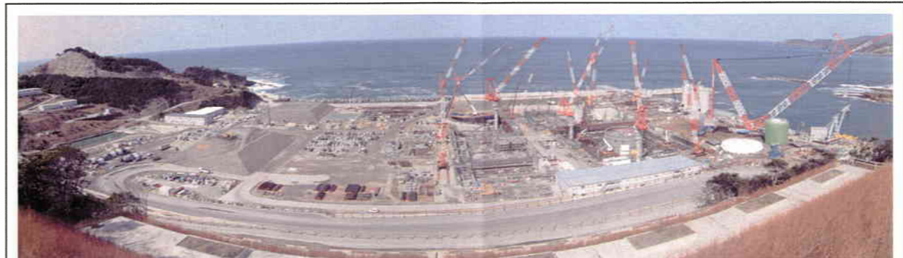
敷地南側からの全景
