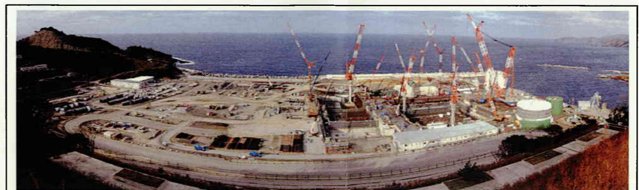
敷地南側からの全景
